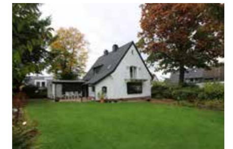
NEUSS-VOGELSANG: EINFAMILIENHAUS Freistehendes Einfamilienhaus, Bj. 1958, 6 Zimmer, 4 Schlafzimmer, 2 Bäder, offener Kamin Grundstück ca. 1.041 m 2 Wohnfläche ca. 180 m 2 Energie 220,1kWh/(m 2 a), Bj. 2019, Gas, G Preis 849.000 Euro (zzgl. 3,57 % Käuferprov.) Kontakt McMakler, Tel. (0800) 500 80 02, www.mcmakler.de
