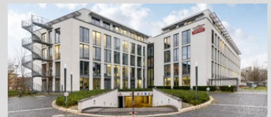
Systemzentrale Sendling, Gmunder Str. 53, 81379 München
